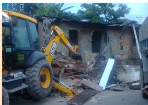
Demolição de casas em área de risco
