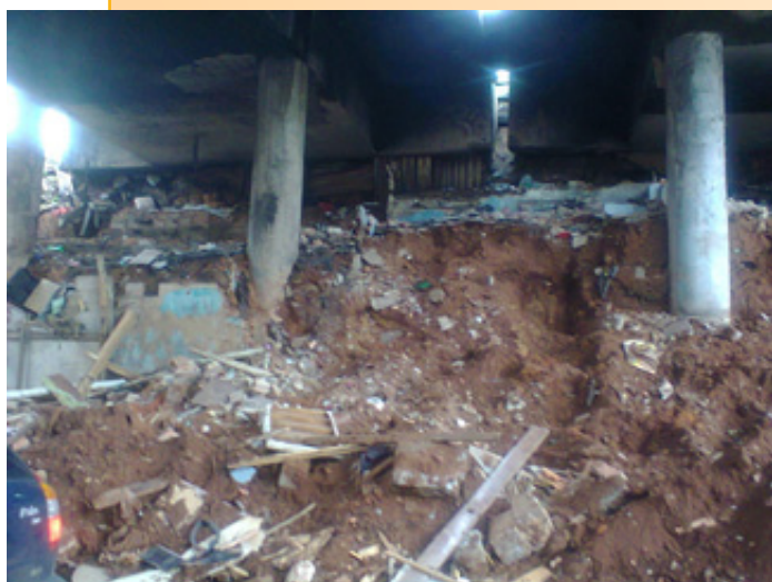
Andamento das obras no Anel Rodoviário
